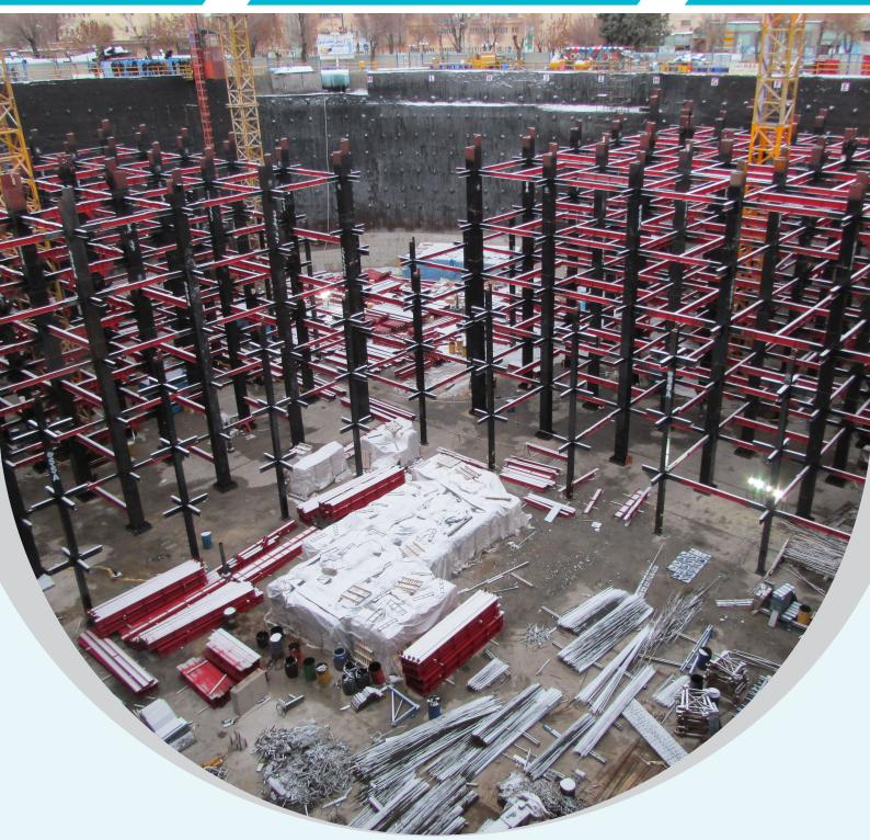
پروژه برج دوقلوی شهرداری شهرکرد در زمینی به مساحت ۶۰۰۲ مترمربع، با زیربنای ۷۸۰۰۰متر مربع در ۲ بلوک، هرکدام با ۲۶ طبقه شامل: ۵ طبقه پارکینگ در زیرزمین با متراژ ۲۸۵۰۰ مترمربع و ۲۱ طبقه با کاربری تجاری، اداری، خدمات پزشکی، فرهنگی و ورزشی با اسکلت فلزی و سقف عرشه فولادی و نماها، کامپوزیت و سفال کراتون به صورت اجرای خشکه چینی و شیشه طراحی گردیده است که در حال حاضر دارای پیشرفت فیزیکی حدود ۳۵ درصد میباشد
